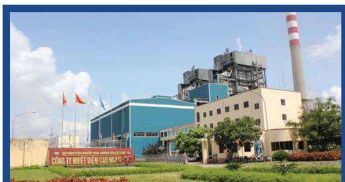
Cao Ngan Thermal Power Plant
